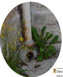
6 Descente EP non raccordée
