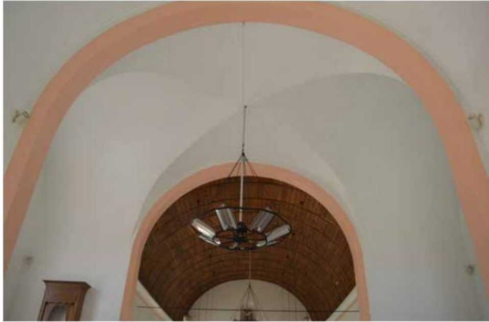
1- Voûte du transept
