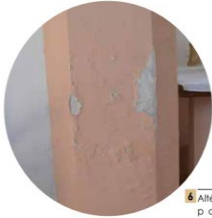
5 Altération des parements
