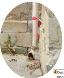
5 Remontées capillaires , dégradation de l'enduit
