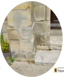
7 Descente EP non raccordée
