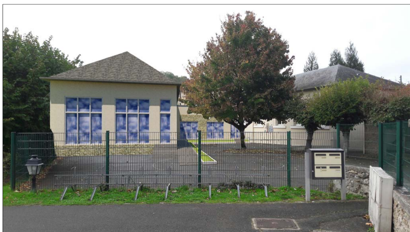
DCE 24 Grande Rue - 78126 Aulnay-Sur-Mauldre construction d'un bâtiment pour les services techniques, extension école la réalisation de la nouvelle mairie et la création de logements
